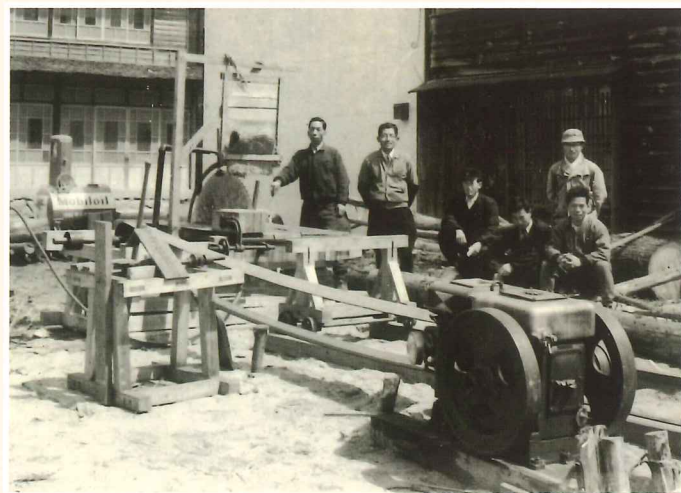
移動製材。大きな機械を使って丸太を板や柱にしたよ。
